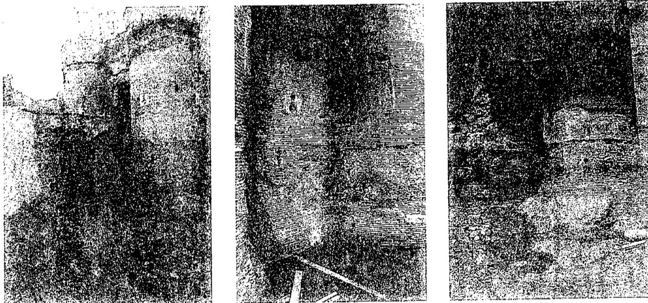
a) El puente antes de la intervención. b) Bajo el puente. Arranque del arco original de apoyo del puente levadizo. Daños en fábrica y troneras en el tramo inundaible. c) Cuerpo de entrada tras la excavación. Rechapados modernos (luz de paño, algunos incluso con sus zapatas).
